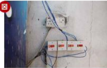
شكل رقم ٦: الأسلاك والأنابيب الخارجية المكشوفة
